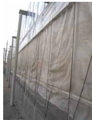
側窓の侵入防虫ネット
