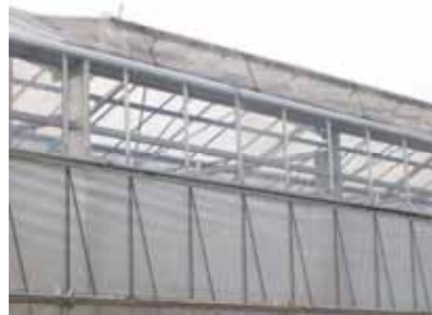
天窓の外側の防虫ネット張り
