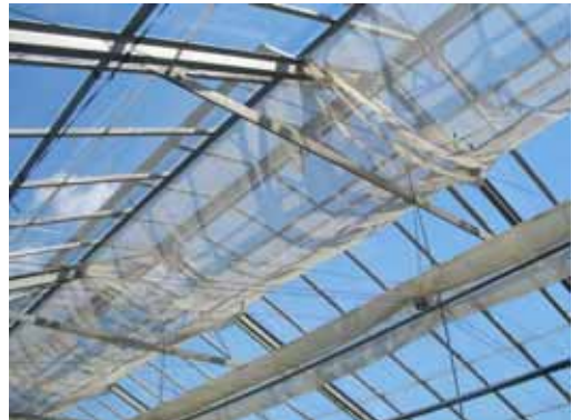
内側からの天窓の防虫ネット張り
